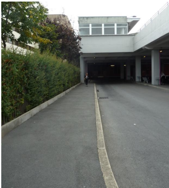
Quais de régulation Albatrans (situés au fond de la gare routière)
